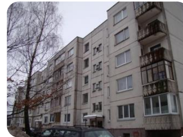
5-ių aukštų, 20-ties butų (ser. 111-120B-04/1), stambiaplokštis daugiabutis gyvenamasis namas
