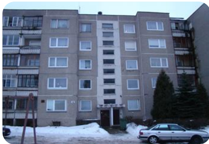
5-ių aukštų, 20-ties butų (ser. 111-120B-04/1), stambiaplokštis daugiabutis gyvenamasis namas
