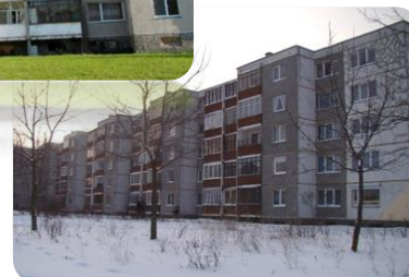
1-464 LI (1968–1978 m. statyba) stambiaplokščių daugiabučių pastatai
