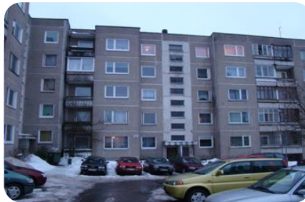
5-ių aukštų, 20-ties butų (ser. 111-120B-04/1), stambiaplokštis daugiabutis gyvenamasis namas
